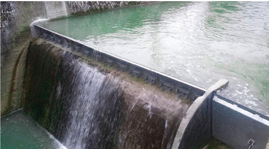
Abb. 1: Federwehr auf einer Wehrkrone
